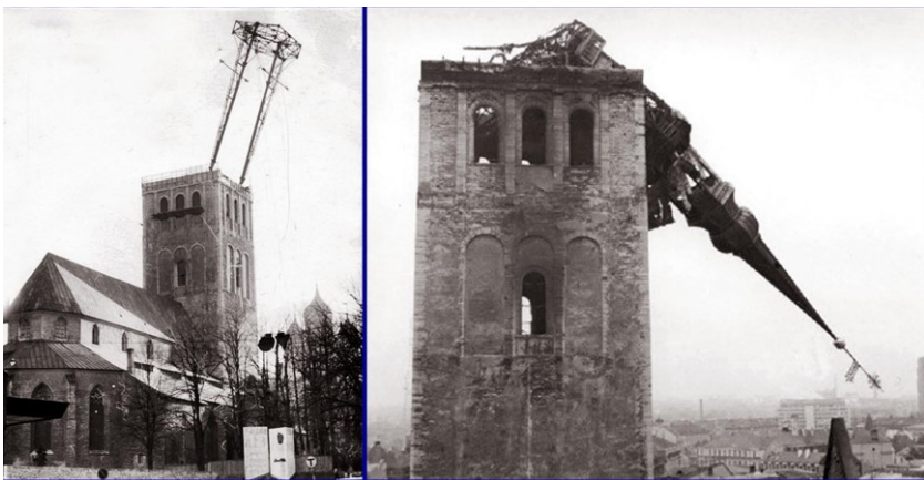
Niguliste. Подготовка к установке нового шпиля. Шпиль, рухнувший после пожара. Фото Владимира Петрова, 1973 год.
