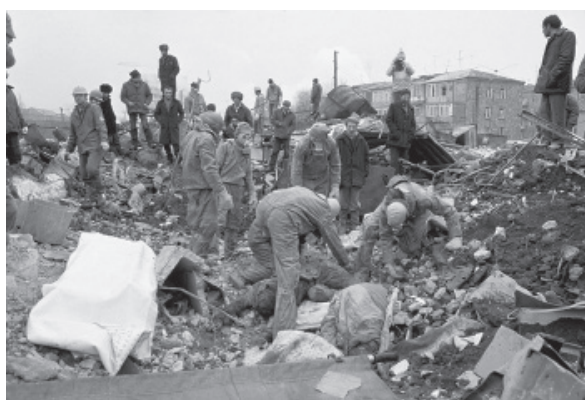
Спасательные работы в Спитаке
